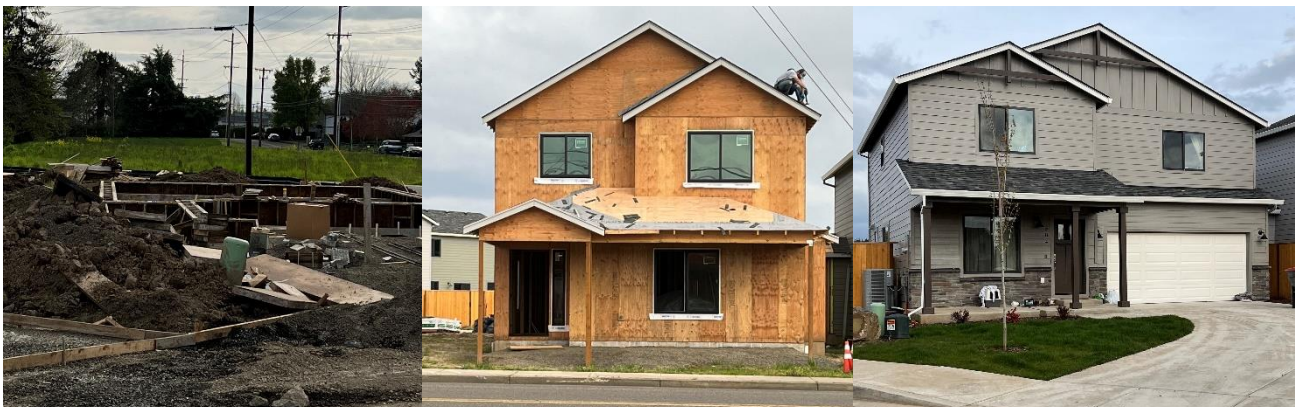
Filbert Pointe Subdivision Construction
